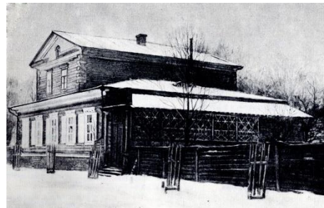
Дом Ушинских в г. Новгород-Северский
